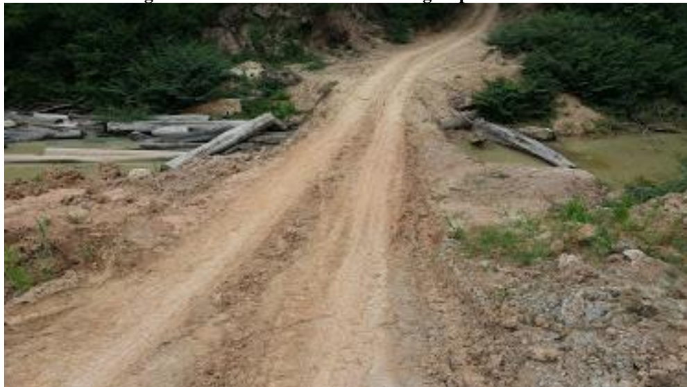
Figura 18: Ponte construída sobre o Igarapé Vai Se Ver
