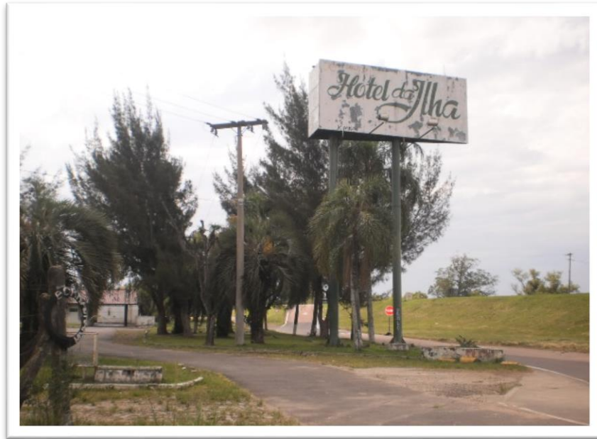
Fotografia 3 - Área do Hotel da Ilha
