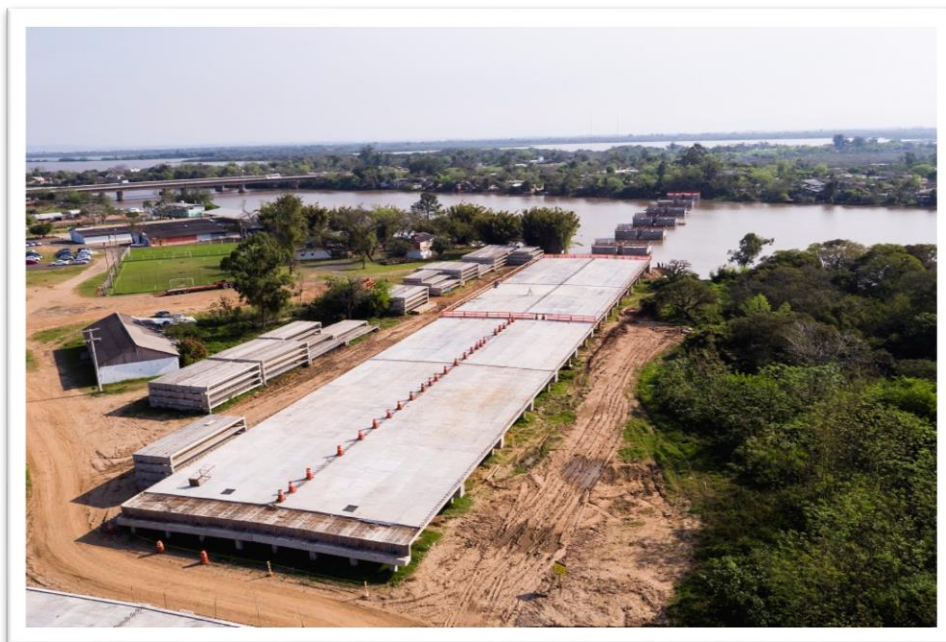
Figura 6 - Obras sobre a Ilha do Pavão e pilares próximos da Ilha Grande dos Marinheiros
