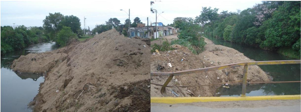
**Figura 22: Fotos da limpeza do arroio Feijó como procedimento preventivo contra as cheias, antes da chegada do inverno, quando a ocorrência de chuvas aumenta. (Coordenadas: Lat. 29°59'51.81"S; Long. 51° 5'16.75" O) Foto: I.S. Ronconi - abril/2018.**
