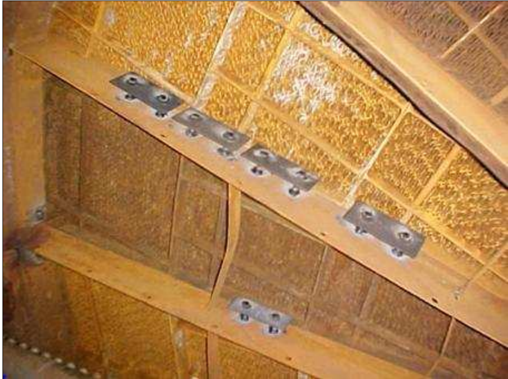
Figura 4.38- Corpos-de-prova instalados internamente no PAF (SCHULTZ et al. , 2003).
