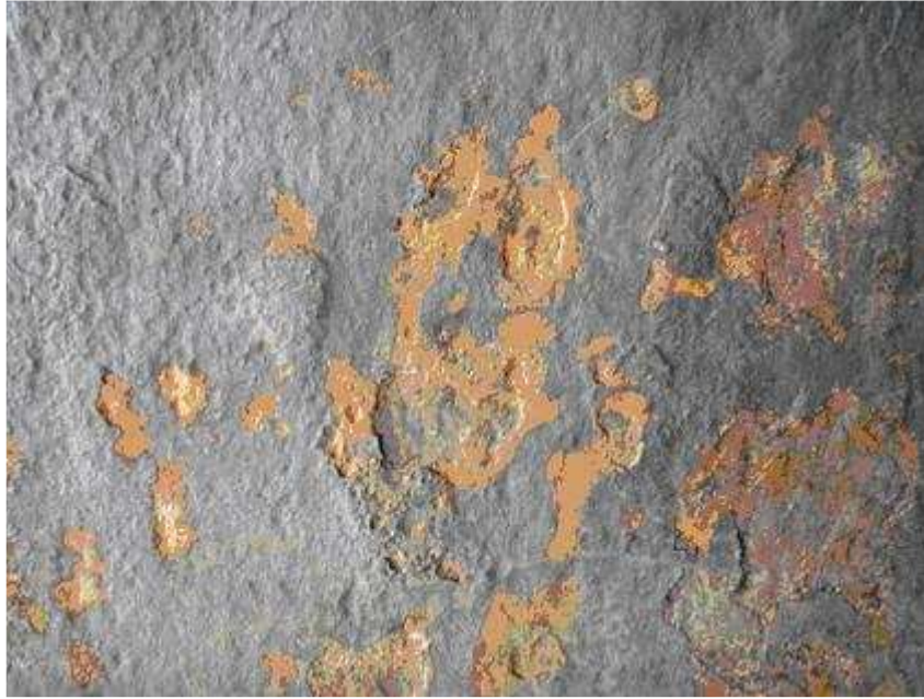
Figura 6.9- Regiões descoladas do revestimento de \text{Nb}_2\text{O}_5 , expondo o substrato de aço ao carbono, inspeção em 31/10/2007 (REDUC, 2007b).
