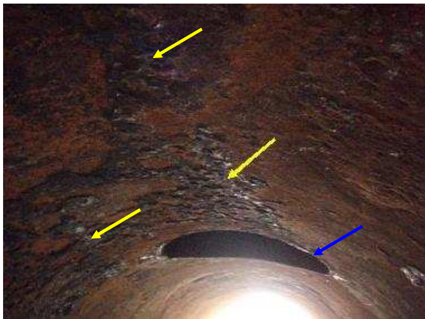
Figura 6.2- Foto da parede interna do casco, mostrando abertura para entrada de fluido, inspeção em 07/12/2007 (REDUC, 2007a).
