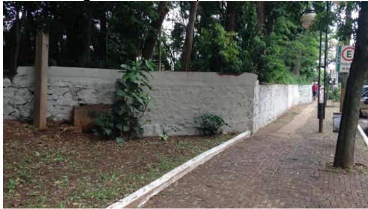
Figura 56 – Muro depois, Londrina-PR
