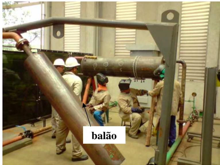
Figura 25 – Área para qualificação de procedimentos de soldagem e soldadores com sistema de circulação de água. Ao fundo, soldadores executando a qualificação de um procedimento.
