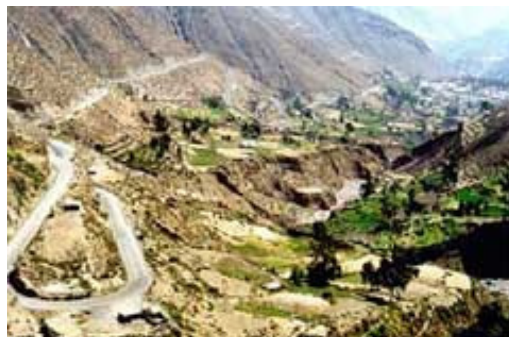
Figura 21 – Carretera Pisco Ayacucho-Via Libertadores, Peru. Fonte: Construtora OAS. < www.oas.com.br >
