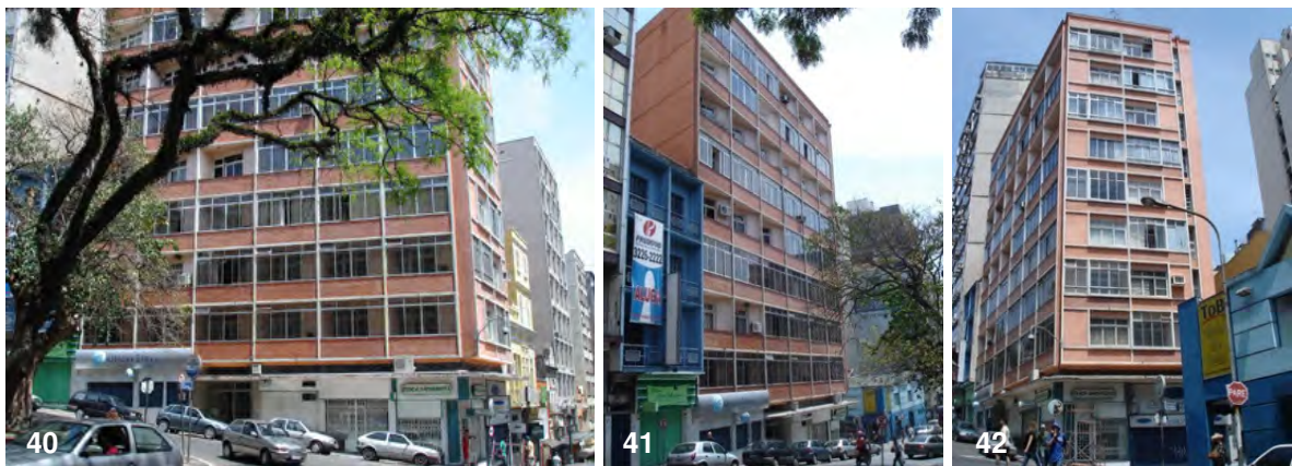
Figura 40: Fachada leste do Edifício São Francisco vista desde a Praça Dom Feliciano. Figura 41: Fachada leste do Edifício São Francisco vista desde a Praça Dom Feliciano. Figura 42: Fachada norte do Edifício São Francisco vista desde a Rua Senhor dos Passos. Fonte: Fotos da Autora.
