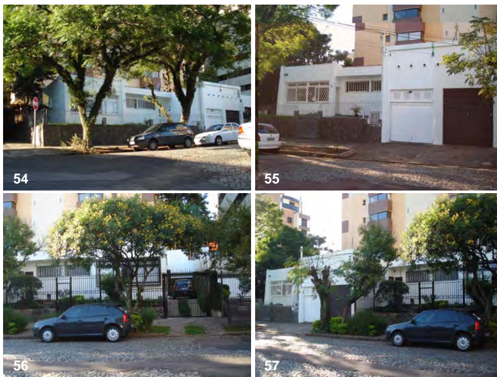
Figuras 54, 55, 56 e 57: Residência Rua Itaboraí. Fotos das residências. Fonte: Fotos da Autora.
