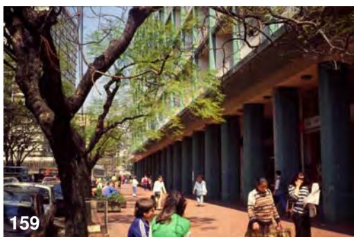
Figura 159: Edifício Esplanada. Fonte: Cláudio Calovi Pereira.
