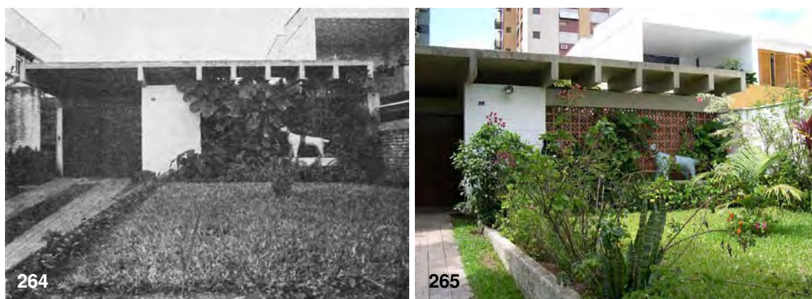
Figura 264: Residência do Arquiteto. Foto da fachada principal.
