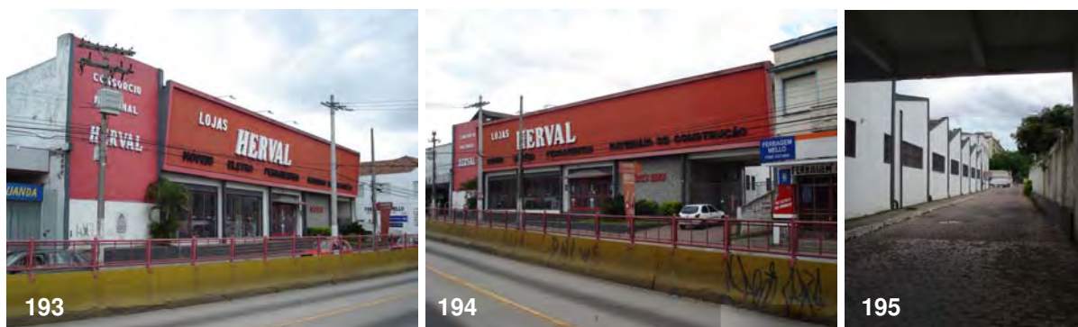
Figura 193 e 194: Masi & Cia. Ltda. Fachada principal.
