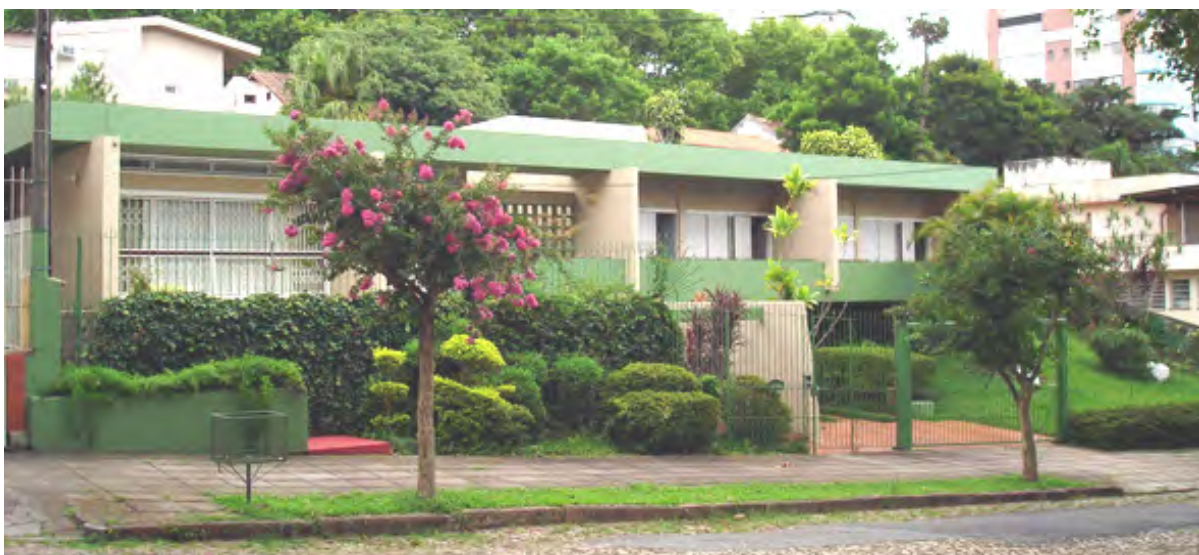
Figura 312: Residência Hélio Roca Bragança. Fachada principal. Fonte: Foto da Autora.
