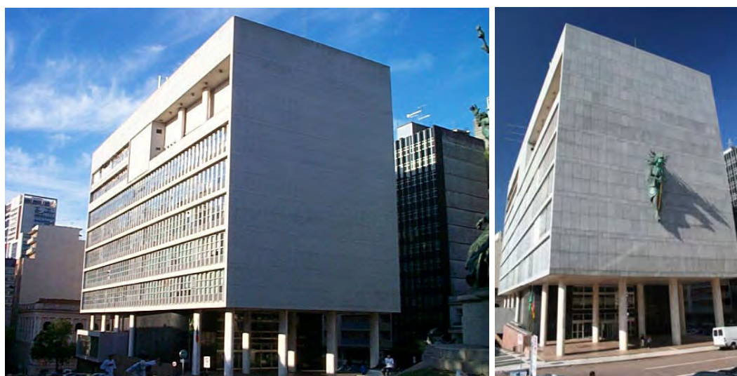
Figura 233: Palácio da Justiça. Aspecto do edifício antes da reforma.
