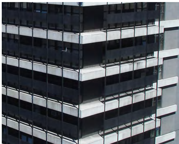
Figura 332: Edifício CRT. Detalhe das lajes em balanço revestidas em pastilhas brancas, sombreando o plano de vidro recuado, e a trama metálica preta do quebra sol aplicada sobre as lajes.
