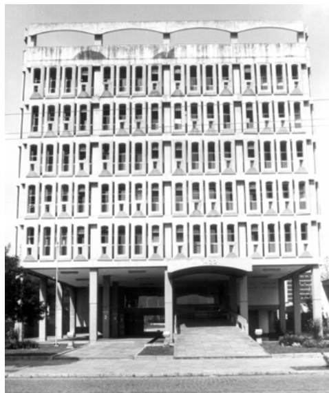
Figura 376: Edifício-Sede das Juntas do Tribunal do Trabalho, 1974. Projeto de Emil Bered, José Antônio Vieira, Maria Helena Bered e Walter Bered.
