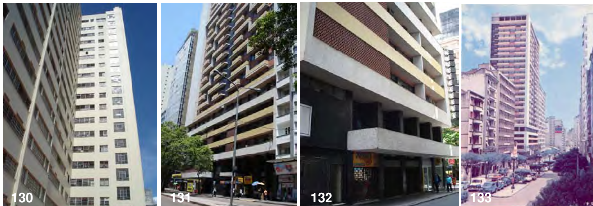
Figura 130: Fachadas sul e oeste do Edifício Jaguaribe.
