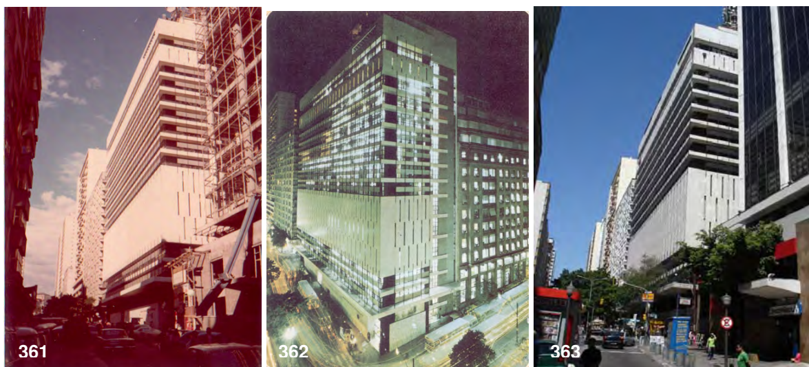
Figura 361: Edifício CRT logo após a conclusão do Bloco B.
