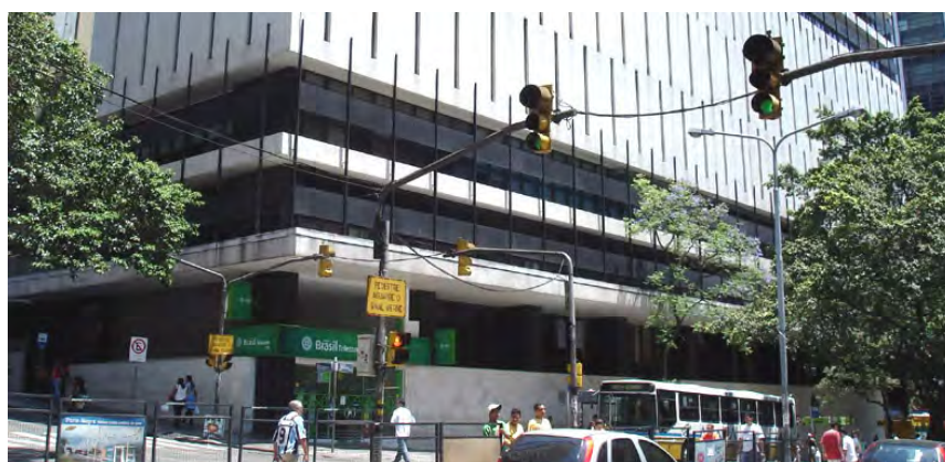
Figura 347: Edifício CRT, Avenida Salgado Filho esquina com a Rua Mal. Floriano Peixoto.
