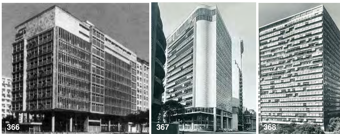
Figura 366: Edifício IRB. Fachada norte.
