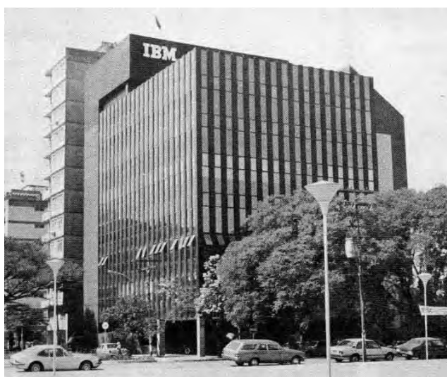
Figura 377: Edifício IBM, 1971. Projeto de João Carlos Paiva da Silva e Paulo Roberto Almeida.
