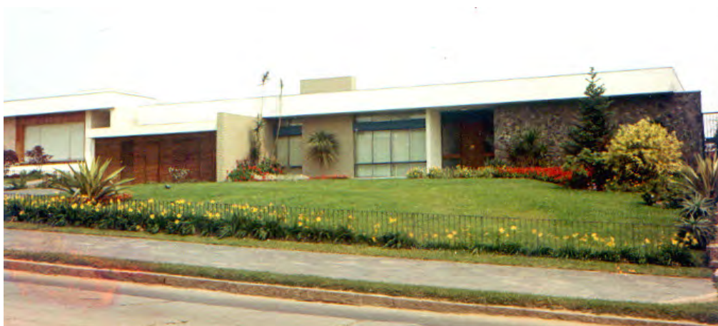
Figura 284: Residência Haroldo Dias Paiva. Fachada principal.
