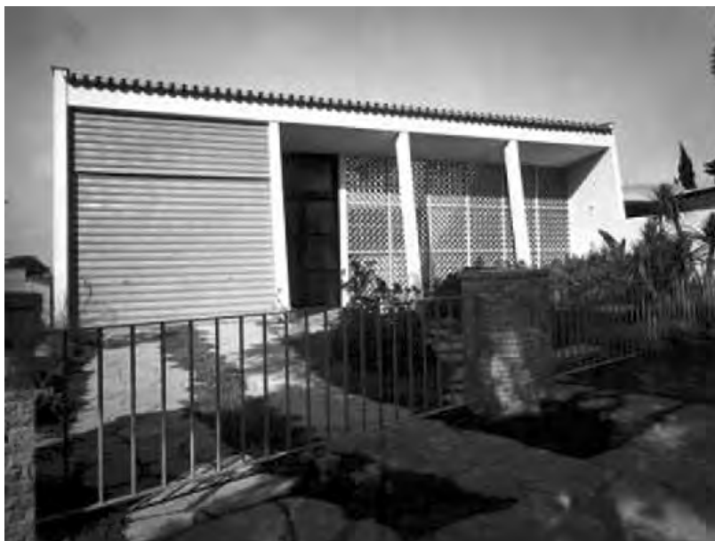
Figura 64: Residência Eugênio Noes. Foto da fachada principal.
