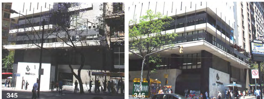
Figura 345: Edifício CRT, acesso pela Avenida Borges de Medeiros.
