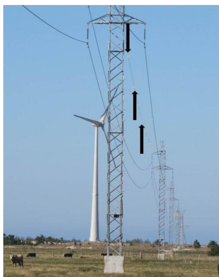
Figura 1. Trecho sinalizado da LT – PET. Flechas pretas apontando a localização dos sinalizadores. Foto: André Barcelos.
