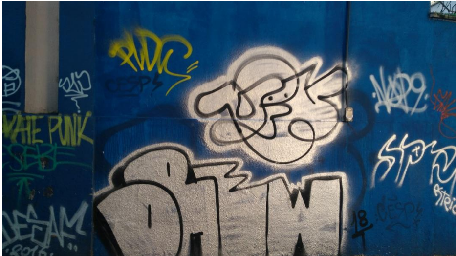
Tags e outras intervenções na Rua Cel. Fernando Machado.
