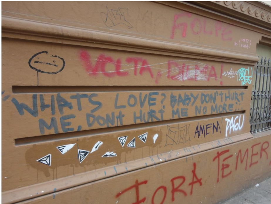
Pichações e outras intervenções na Rua Ge. Lima e Silva.
