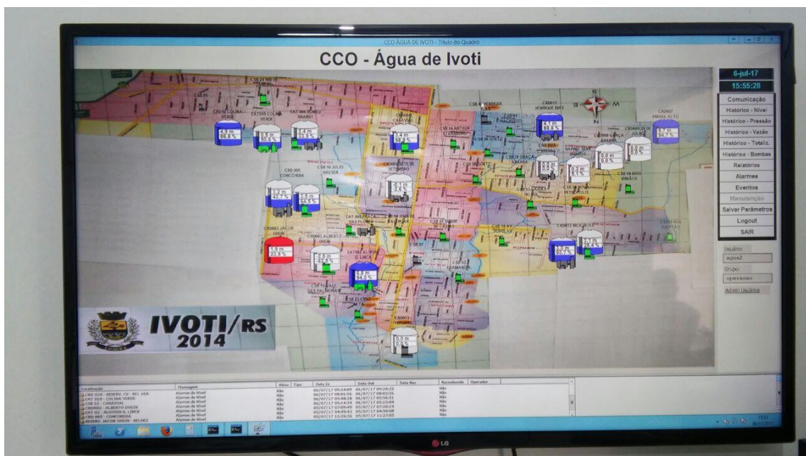
Figura 15 – Foto do monitor do Centro de Controle e Operações, que informa os níveis dos reservatórios e o funcionamento das bombas
