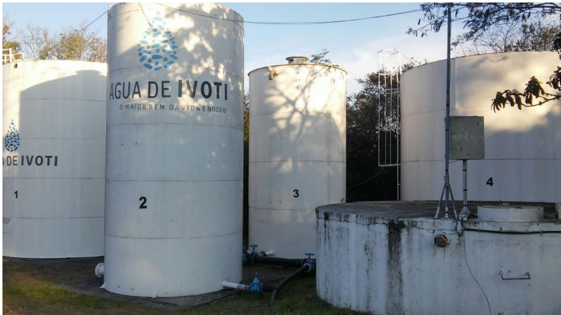
Figura 23 - Unidade de captação de água com vários reservatórios apoiados e um reservatório semienterrado
