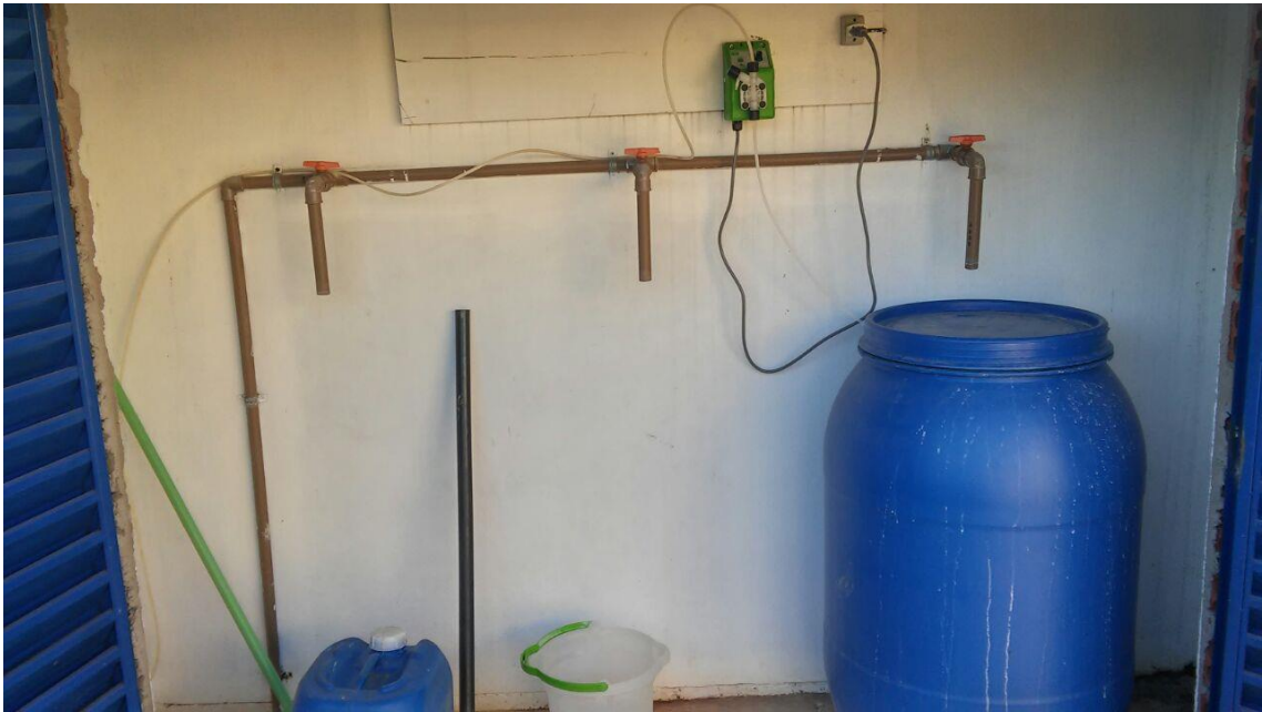
Figura 25 - Depósito de produtos químicos com dosador automático para desinfecção da água bruta aduzida para armazenamento
