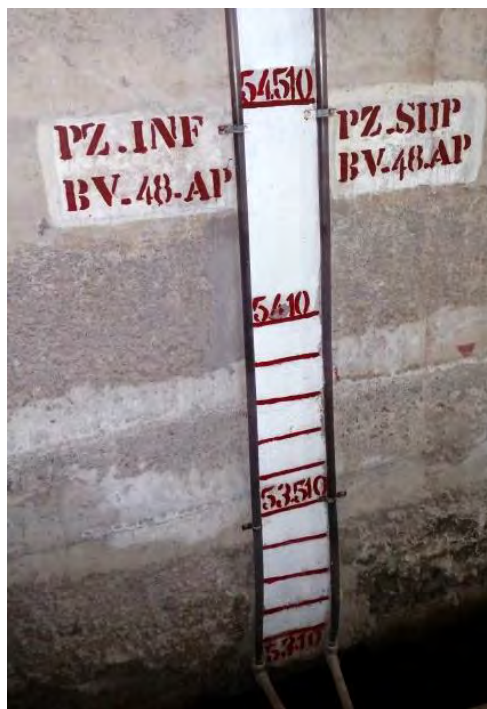
Figura 39 – PTAs instalados no bloco B17
