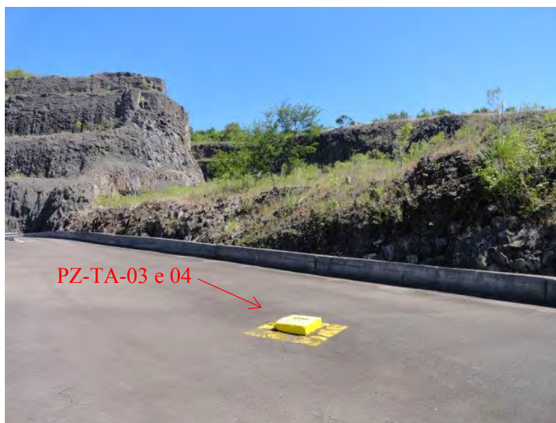
Figura 38 – PTAs externos localizados na ombreira direita (Fonte: CEEE-GT, 2016)
