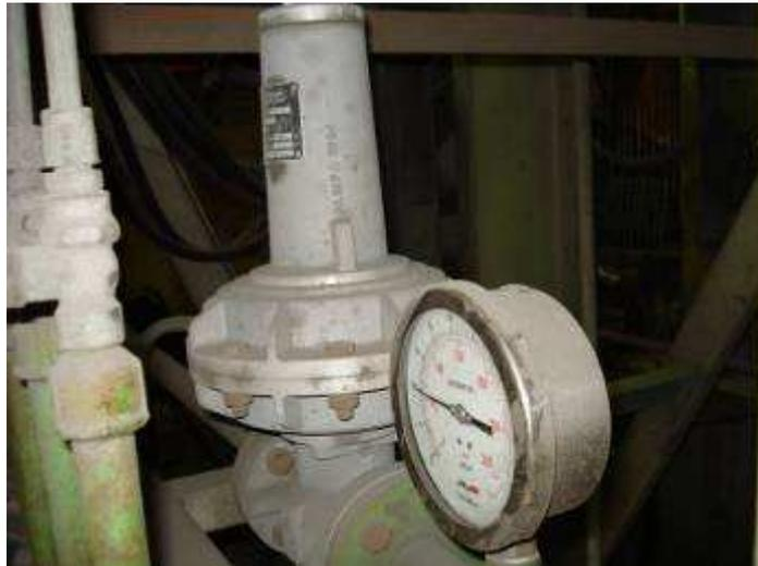
**Figura 30 - Válvula reguladora de pressão de nitrogênio**
