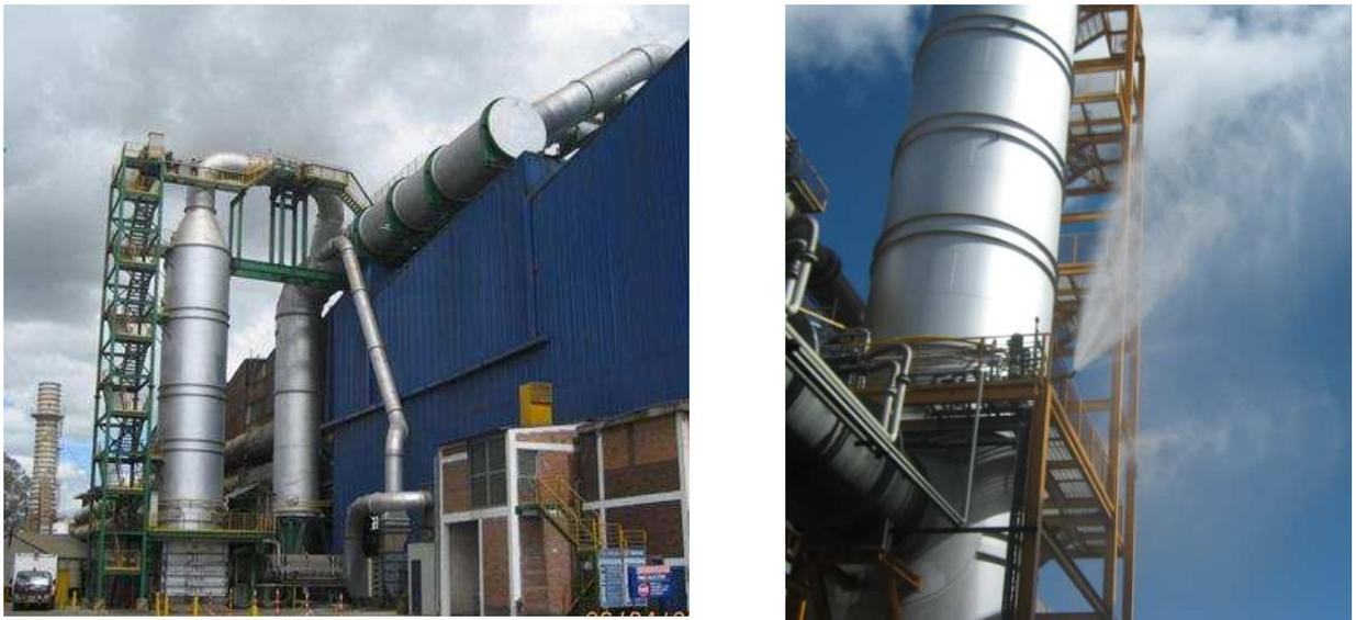
Figura 22 - Foto da esquerda mostra a HQT e dutos, a foto da direita, os bicos sprays da HQT em operação de testes durante a posta em marcha.
