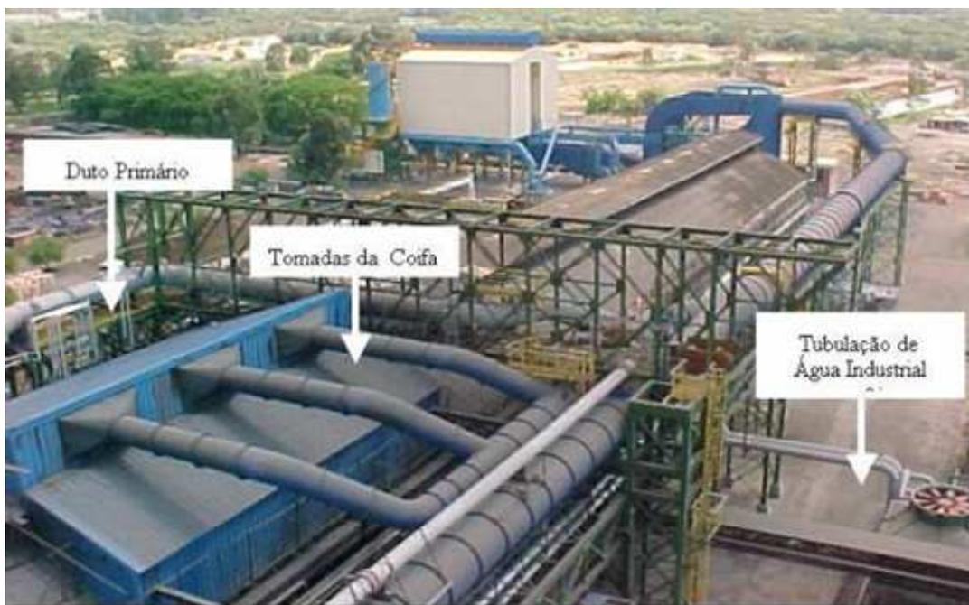
Figura 7 - Foto aérea da coifa com dutos secundários, vista parcial dos dutos primários e tubulação de água utilizada para resfriar os dutos primários.
