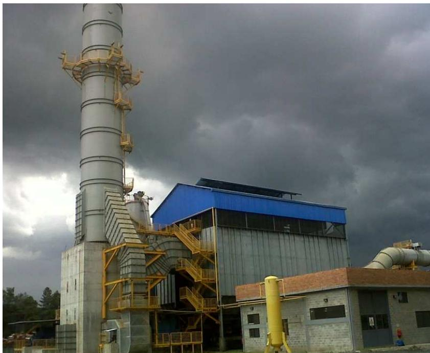
Figura 23 - Vista geral da casa de filtros, dos dutos, da chaminé e dos ventiladores.
