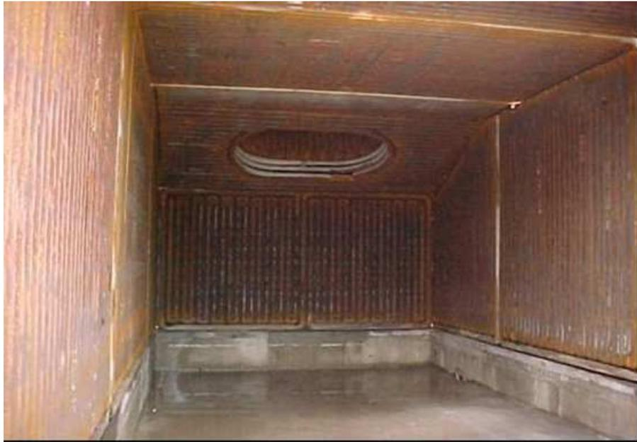
Figura 6 - Vista do interior da câmara de combustão, piso de concreto refratário com paredes e teto montados em painéis resfriados a água.
