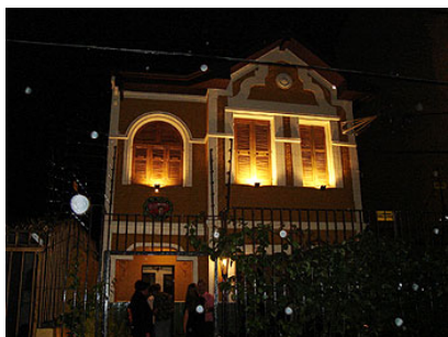
Figura 3.4: Fachada do bar Apolinário.
