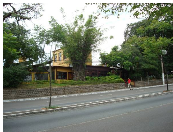
Figura 4.18: Fachada do restaurante Barranco. Fonte: autora, 2008.
