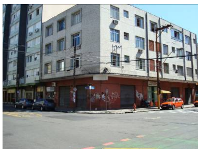
Figura 3.30: Vista da esquina onde se localiza o bar Ossip. Fonte: autora, 2008.
