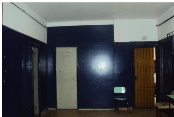
Parte onde as grades não foram pintadas ainda.
