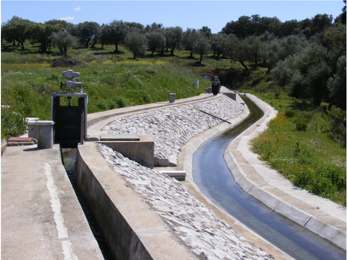
Figura 37 – Vista geral do canal do NUHCC – Canal superior, canal inferior, comportas planas, tomadas de água e caixa de sensores de nível.
