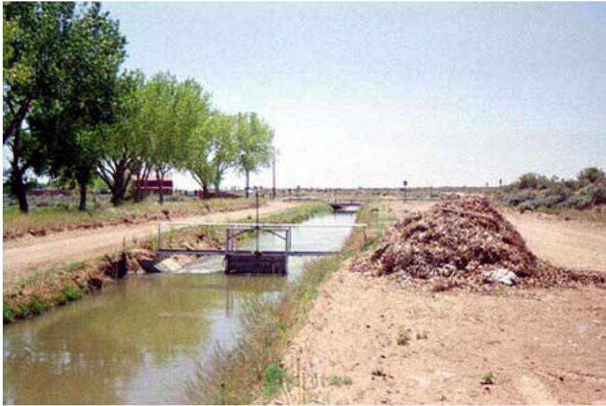
Figura 27 – Detritos acumulados junto à estrutura de controle em canal (Corrales Main Canal) Fonte: ESTADOS, s.d.
