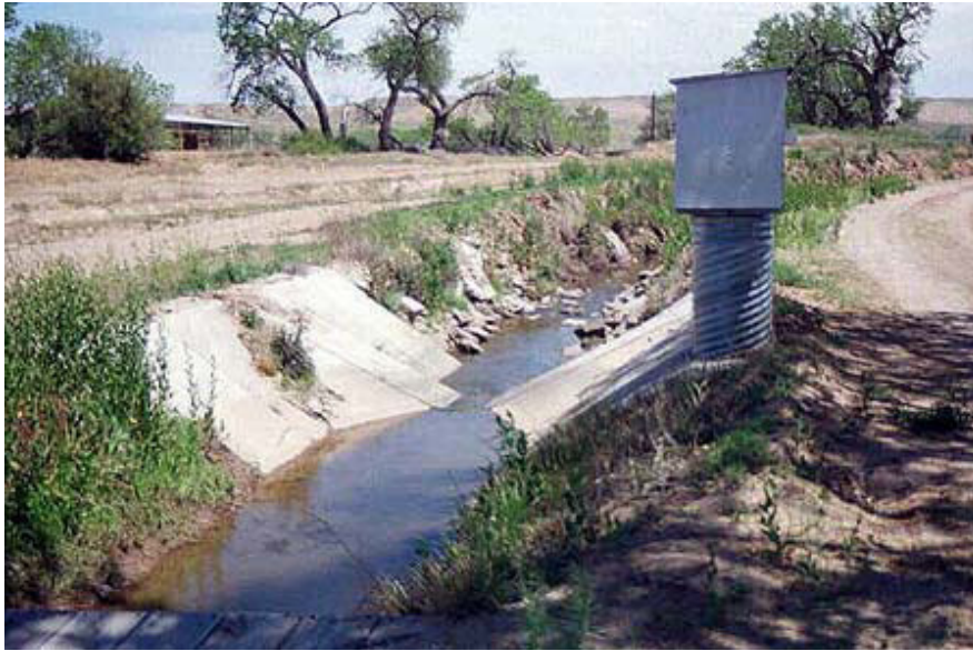
Figura 19 – Vertedor triangular parede espessa em canal de irrigação. Fonte: (ESTADOS, s.d.)
