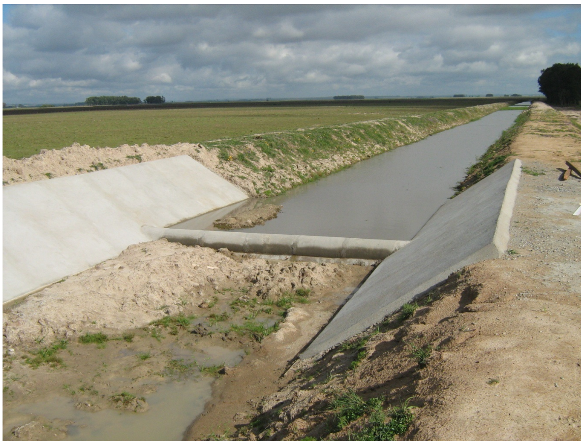
Figura 30 – Vertedor construído com tubos de concreto em canal do sistema de irrigação do arroio Chasqueiro
