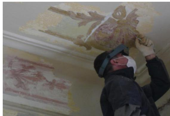
Figura 85b – Detalhe do trabalho de recuperação das pinturas do rodaforno na “sala especial”
