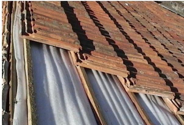
Figura 69 – Detalhe substituição cobertura
