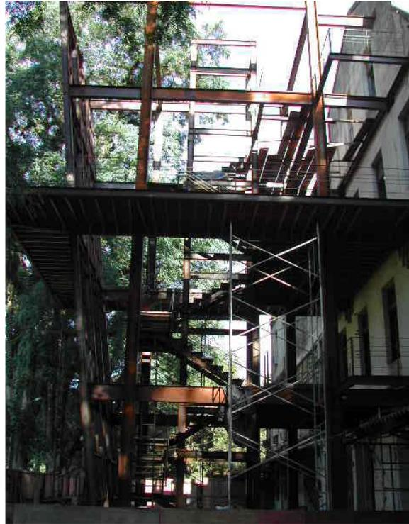
Figura 71 – Estrutura da Torre de Circulação Vertical
