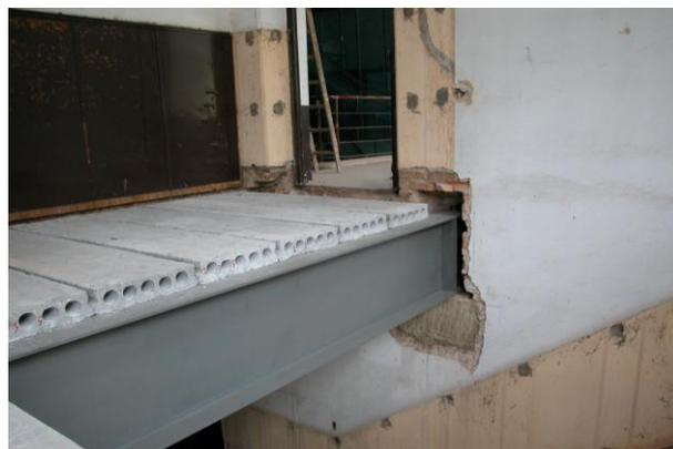
Figura 68 – **Detalhe estrutura do piso**
