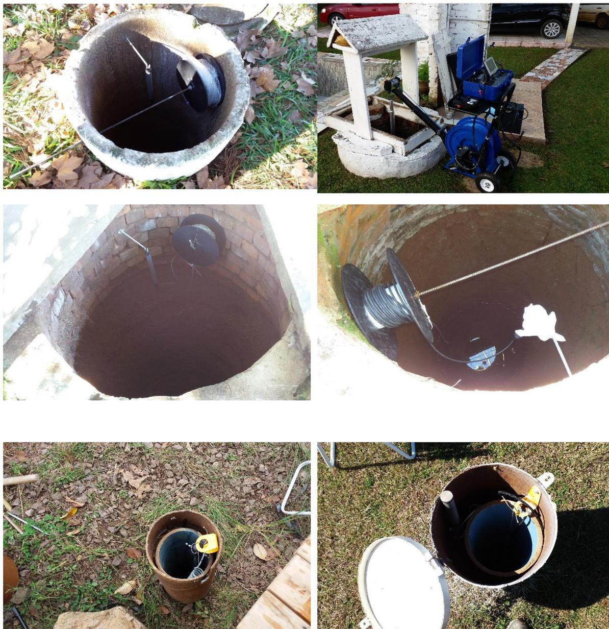
**Figura 40 – Poços utilizados para instalação dos medidores de níveis**
