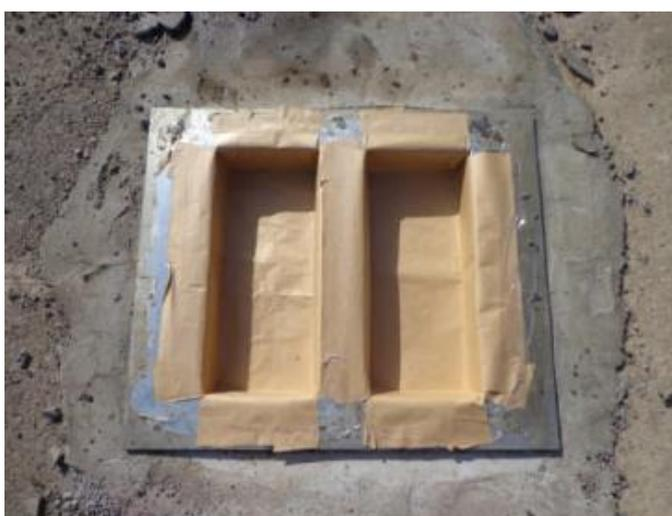
Figura 39 - Uso de papel pardo no positivo para que não ocorresse aderência da massa asfáltica com o molde
