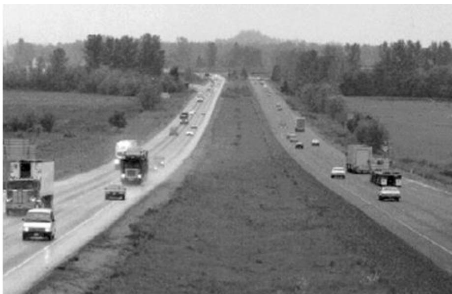
Figura 11 - Pavimento com mistura asfáltica densa (esquerda) vs. pavimento com CPA (direita). (fonte: Kandhal, 2002)
