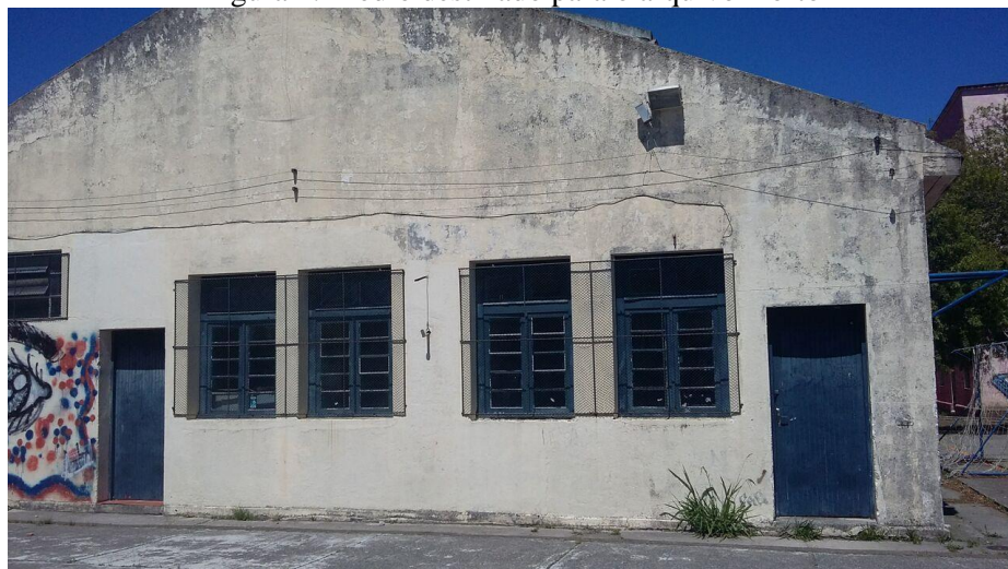
Figura 1: Prédio destinado para o arquivo morto
