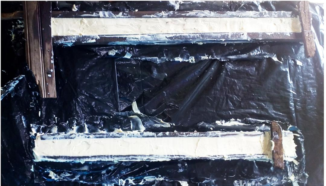
Figura 30. Sabão de soda aplicado dentro dos moldes, 2017.
