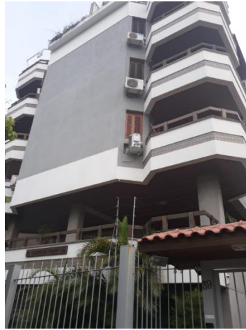
Figura 26 - Fachada do prédio estudado no Caso 1
