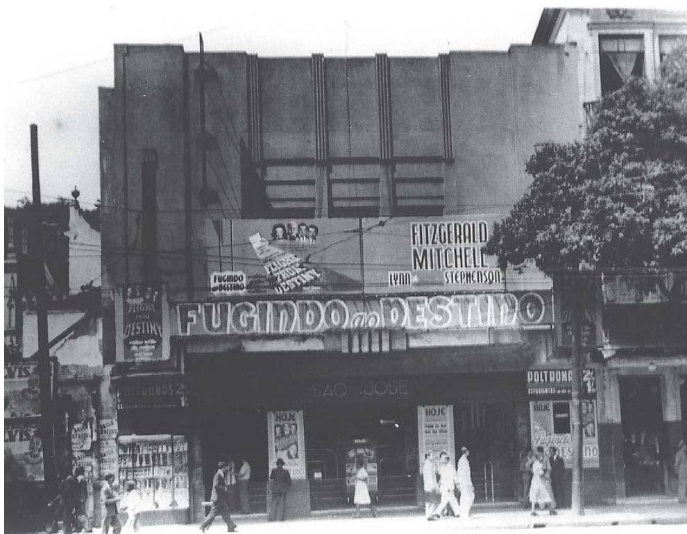
Figura 6 – Fachada do Cine Teatro São José
