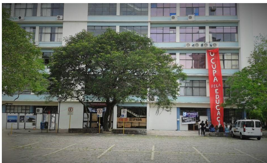
Figura 41 - Fachada frontal da Faculdade de Educação da UFRGS
