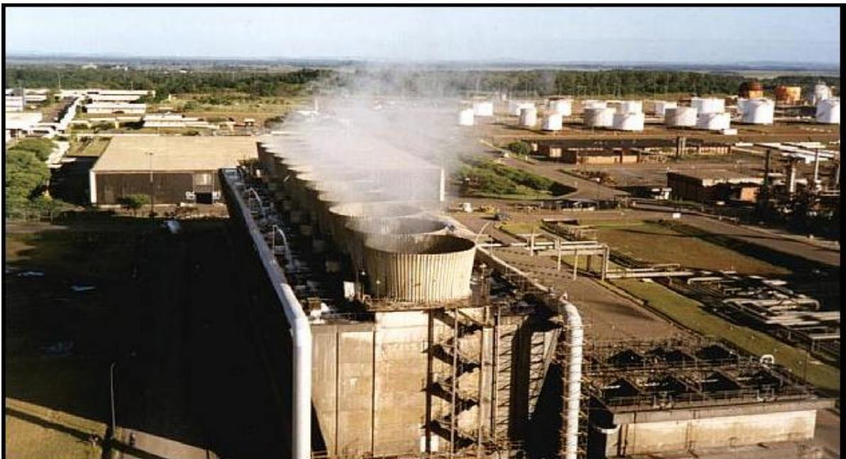
**Figura 3.7.** Fotografia da torre de resfriamento de tiragem induzida localizada na indústria.
