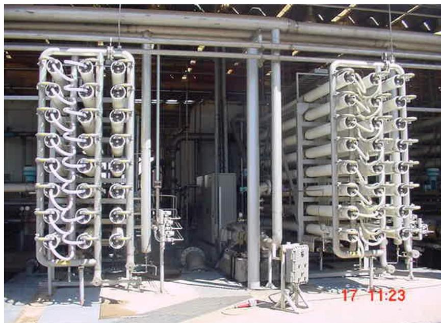
**Figura 3.9.** Fotografia de duas unidades do sistema de osmose inversa da empresa.
