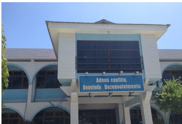
Figura 15. Prédio Direção de Investigação e Desenvolvimento, Caicoli, Díli.
