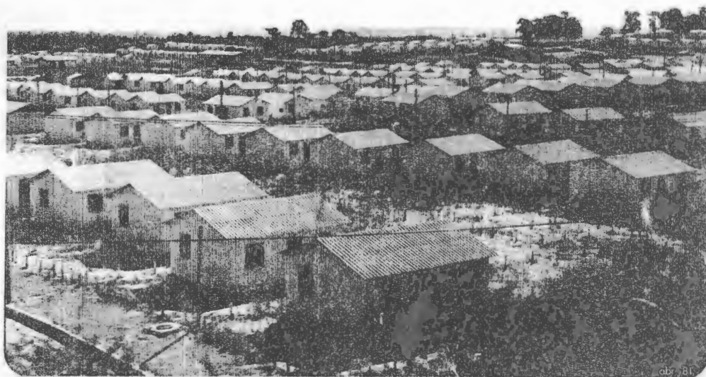
FIGURA 59 - Vista do Conjunto Gravataí N 2 E 1
