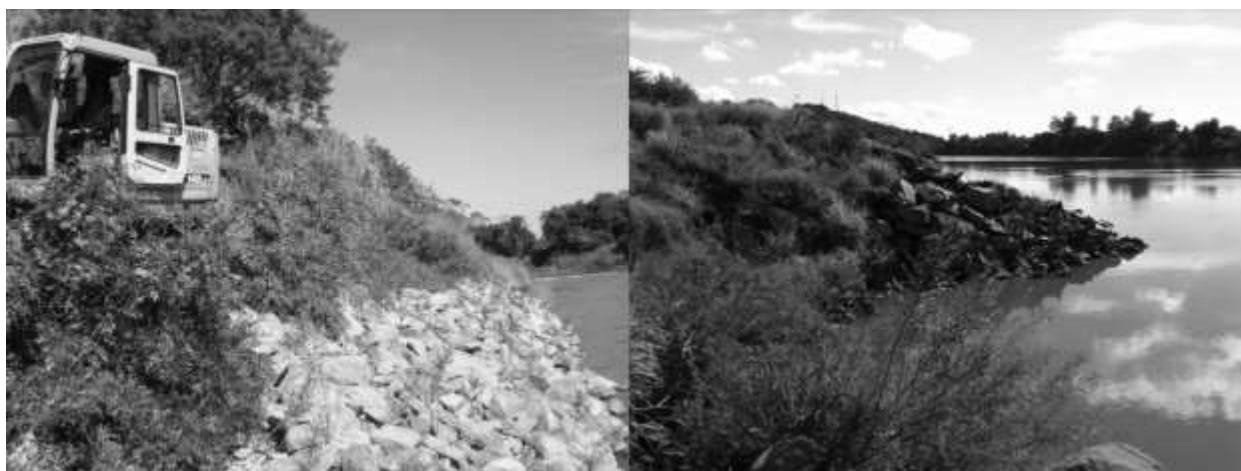
Figura 11 - Técnica de enrocamento, fonte: Dr. Fabricio Jaques Sutuli e técnica de Râmprola, fonte: Biólogo Esmael Barro.
