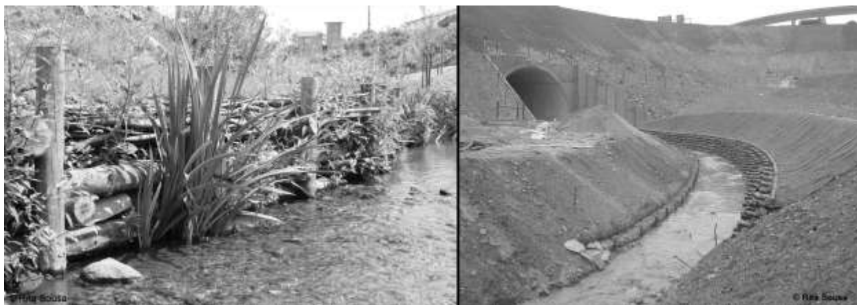
Figura 10 - Técnica de feixes vivos e de Reforço dos declives com mantas orgânicas ou sintéticas.
