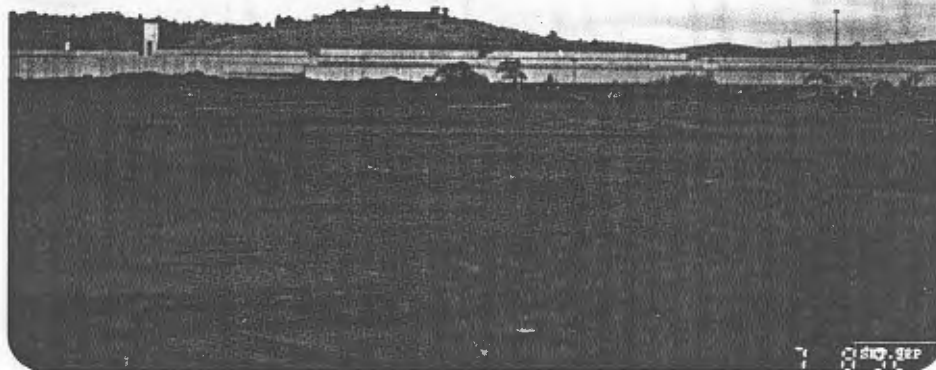
FIGURA 2.3- Parque de Depósito do Resíduo
