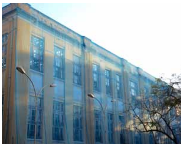
Prédio centenário da Engenharia restaurado (acima) e obras de restauração do antigo Instituto de Química
