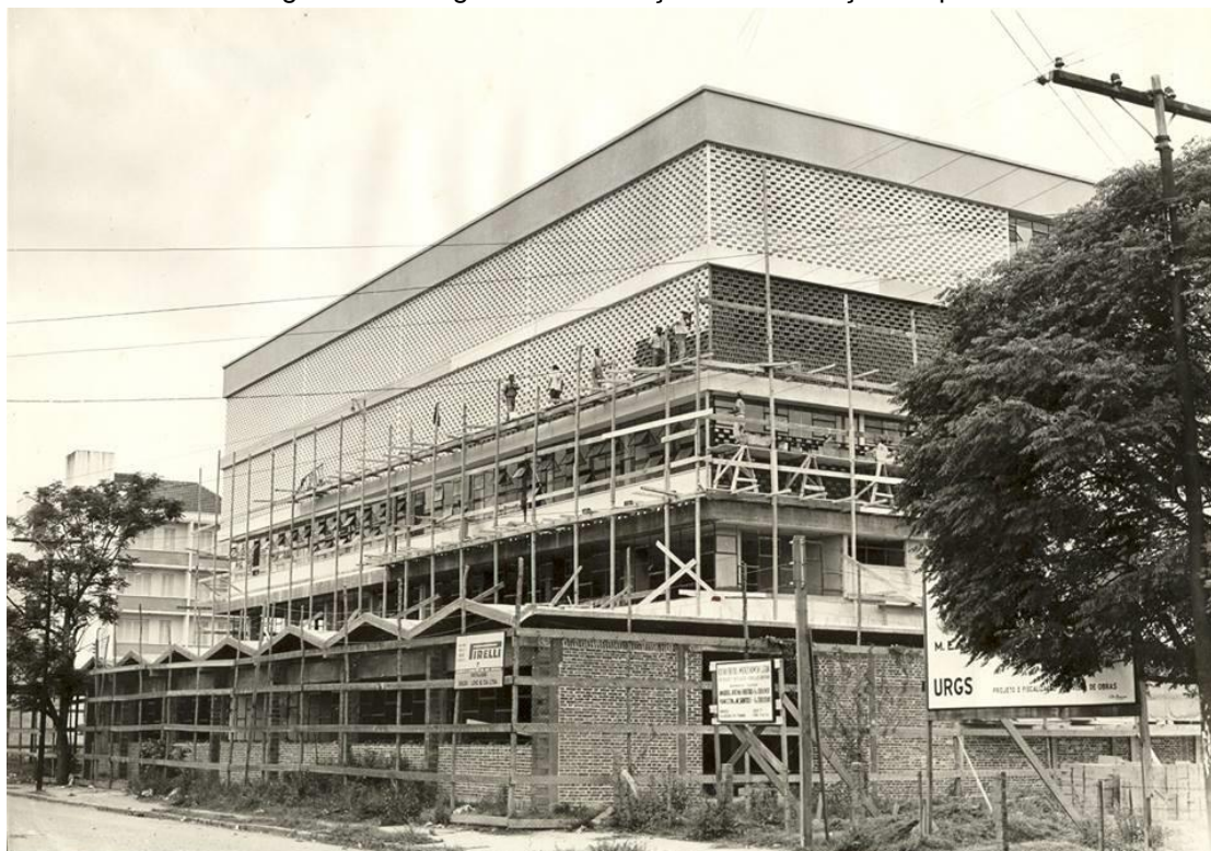
Imagem 6 – Fotografia da execução da construção do prédio
