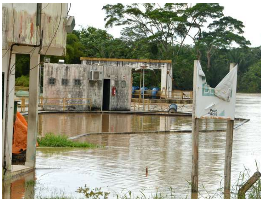
Figura 23 - Estação de Tratamento de Água alagada em 4 de março
