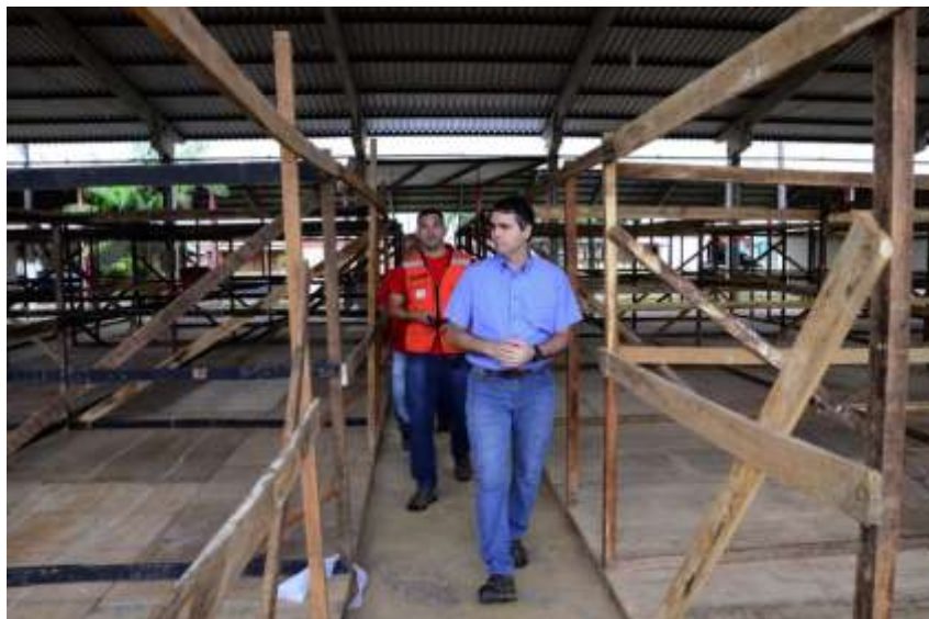
Figura 9 – Prefeito Marcus Alexandre acompanhando construção de abrigos
