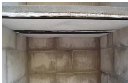
Figura 47: Detalhamento da selagem interna dos compartimentos.
