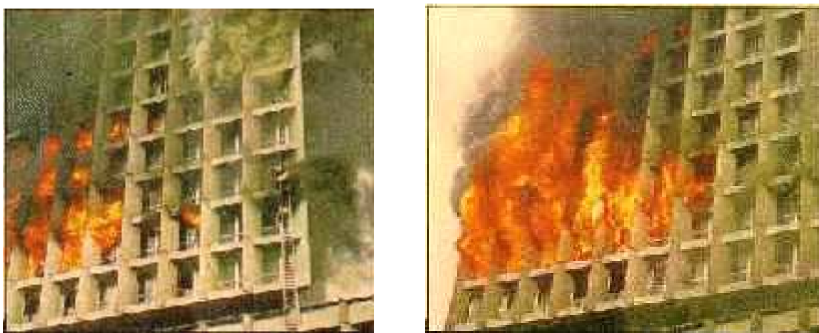
Figura 8: Propagação externa vertical e horizontal do incêndio no edifício Joelma – São Paulo (Revista Eletrônica Bombeiros Emergência)
