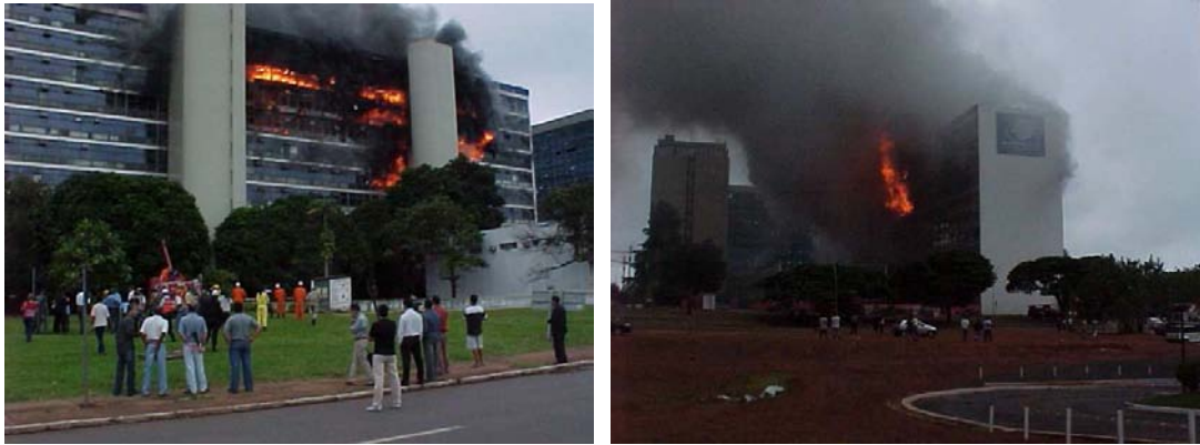
Figura 9: Propagação externa do incêndio na sede do INSS em Brasília – 2005 (Arquivo do Corpo de Bombeiros Militar do Distrito Federal)
