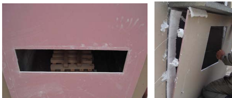
Figura 49: Colocação do gesso acartonado resistente ao fogo mostrando as diferentes configurações de aberturas.
