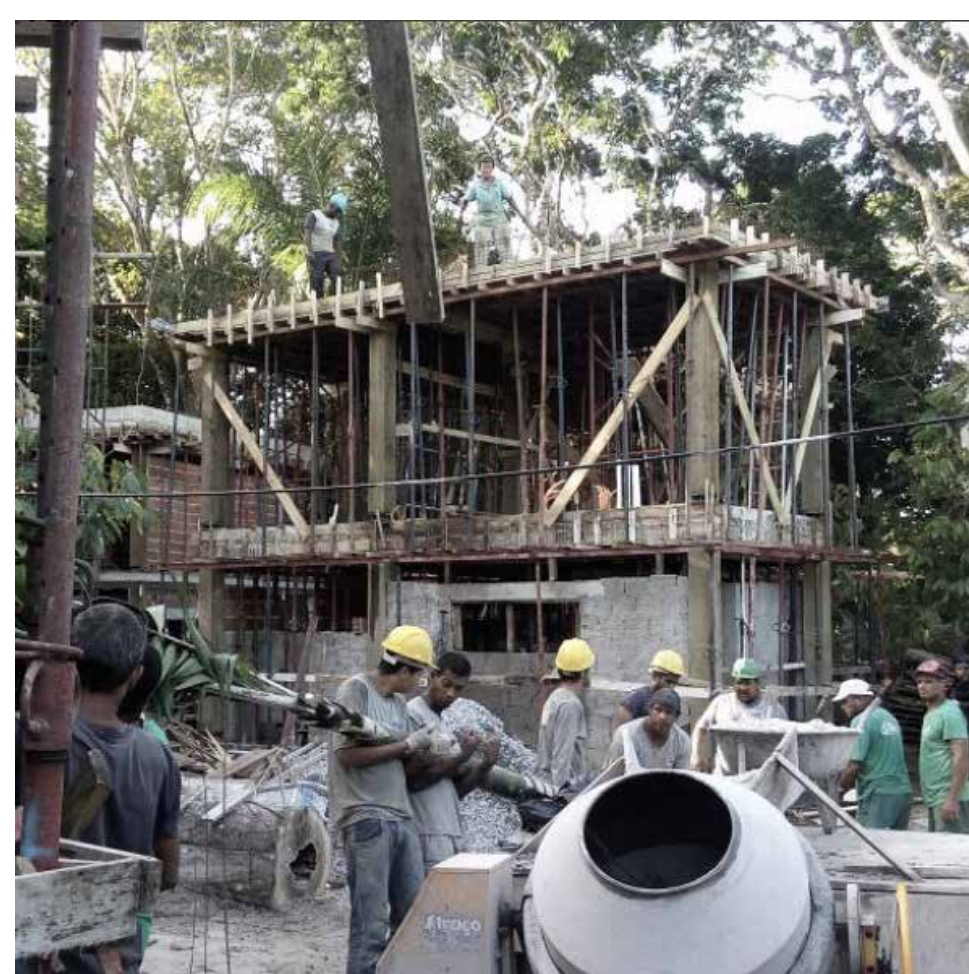
Figura 2 - Fotografia em obra
