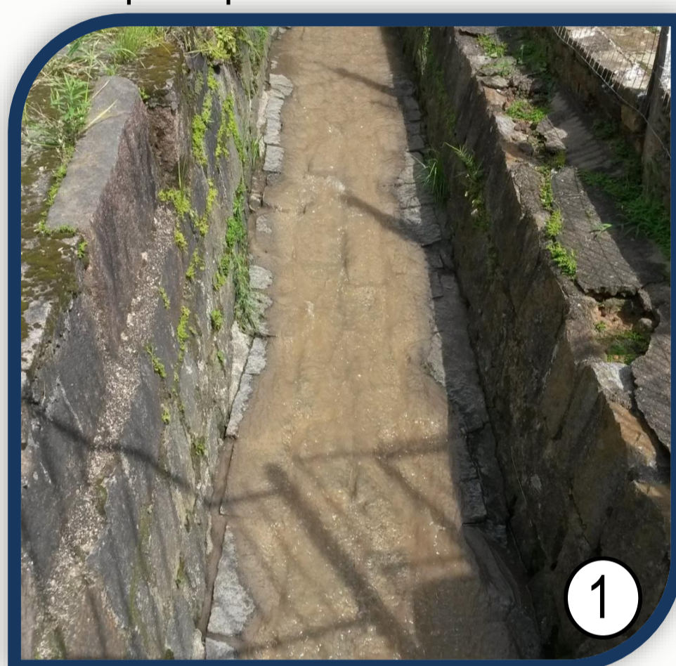
Características após chuva intensa em: 1) trecho canalizado sem depósitos sedimentares; 2) depósito de matacões em leito via paralela ao trecho canalizado do arroio.
