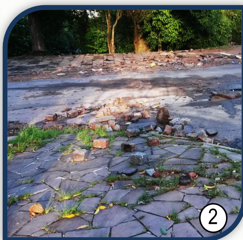
Características após chuva intensa em: 1) trecho canalizado sem depósitos sedimentares; 2) depósito de matacões em leito via paralela ao trecho canalizado do arroio.
