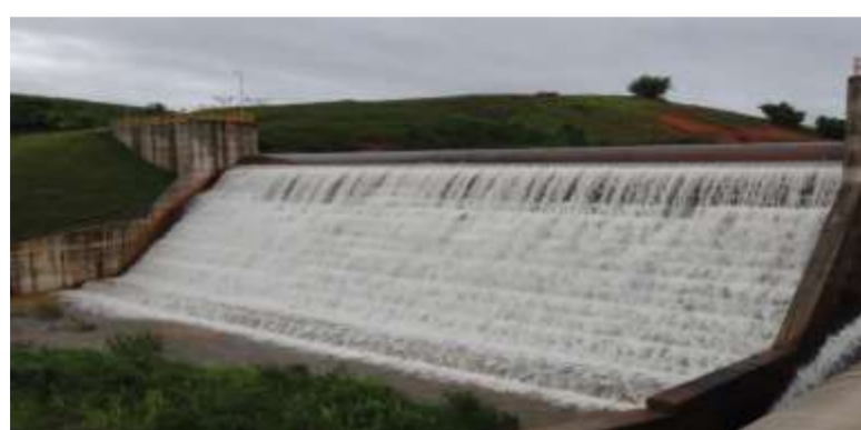
Vertedouro em degraus da Barragem Rio Sirinhaém (PE)
