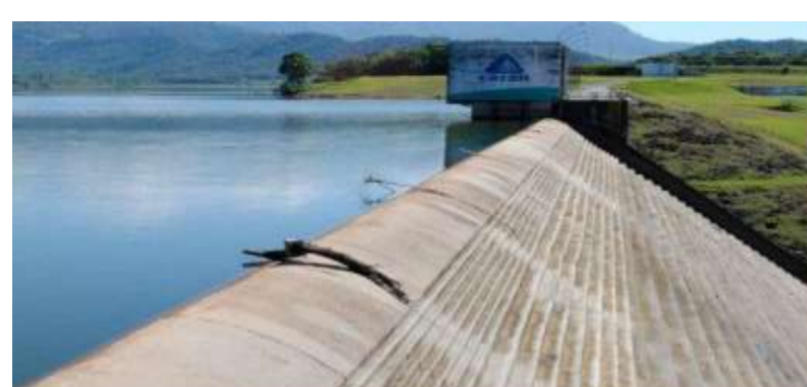
Vertedouro em degraus da Barragem do Rio São Bento (SC)
