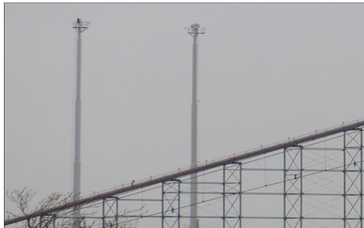
Figura 1.3: Duas das três torres de aço que ficaram de pé no Cedar Point (Jornal The Blade-Section of VertiGo fails at Cedar Point, 2002[85]).
