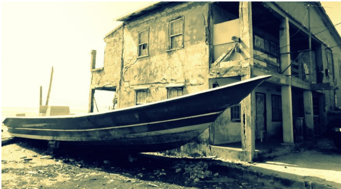
Fotografía 61: Trabajos, San Andrés 2015. Foto de la autora.
