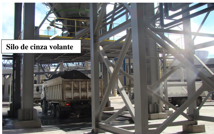
Figura 48 – Vista do silo de armazenamento da cinza volante da fase B
