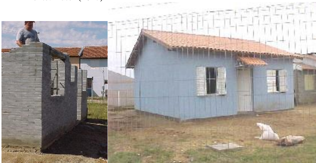
Figura 13 - Casa de blocos cinza/cal construída na Vila tecnológica no Município de Porto Alegre em 2003 – CINCAL. Fonte: Autor (2017)
