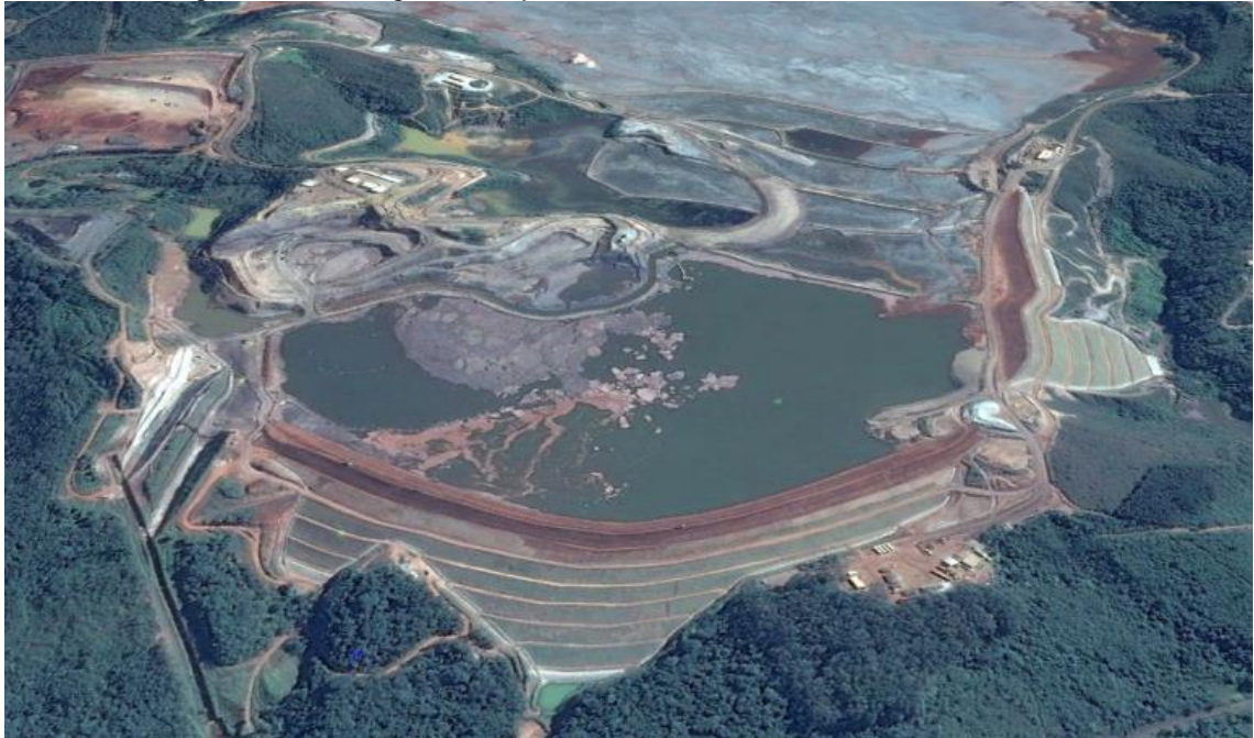
Figura 18 - Barragem de rejeitos de minério de ferro em Minas Gerais.
