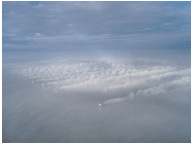
Figura 2.26 – Interação entre esteiras em um parque eólico offshore (Fonte: IVANELL, 2009)
