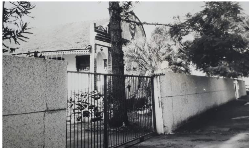
Pilares em pedra na fachada principal em substituição aos originais (fonte: Acervo EPAHC)
