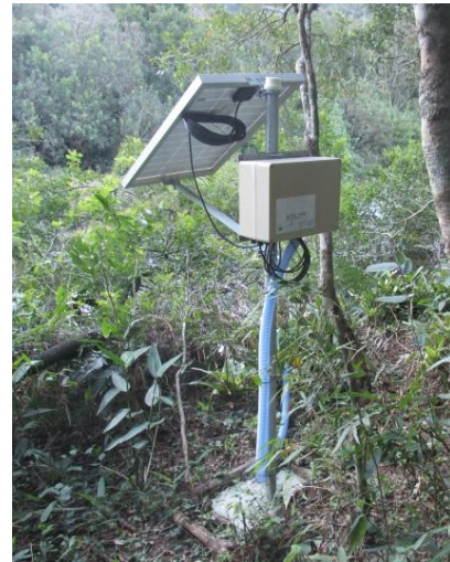
Figura 8 - Sensor de nível instalado no Rio do Boi. FONTE: GPDEN (2018).
