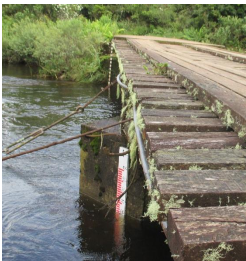
Figura 6 - Régua de nível instalada no Arroio Perdizes.
