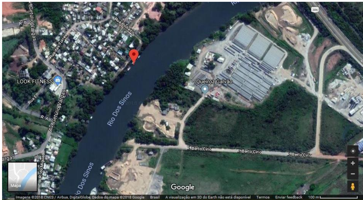
Figura 53 – Estação de captação de água da CORSAN em Nova Santa Rita/RS. Fonte: Google Maps.
