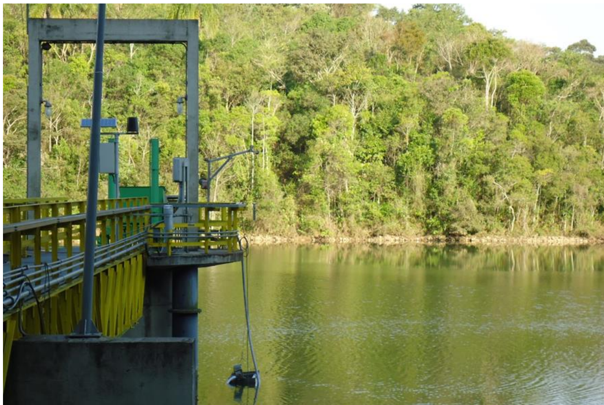
Figura 2 – Estação de Monitoramento Automática – CETESB, no Reservatório Águas Claras, Sistema Cantareira – SABESP. Fonte: Arquivo pessoal da autora.
