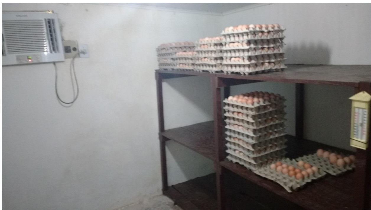
Figura 10. Armazenagem de ovos. Temperatura controlada automaticamente por sistema de ar condicionado.
