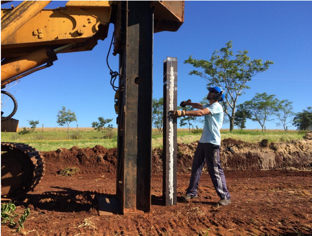
Figura 39 – Cravação de estaca
