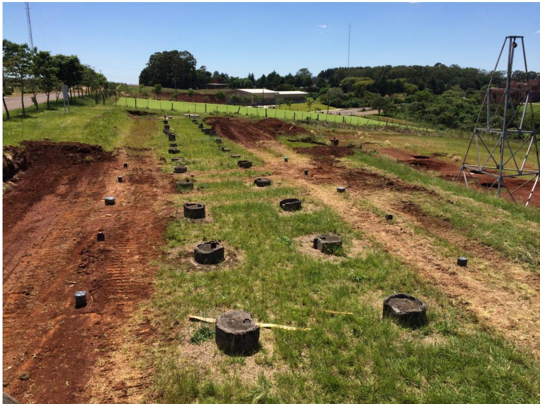
Figura 40 – Estacas cravadas alternadas as estacas de concreto
