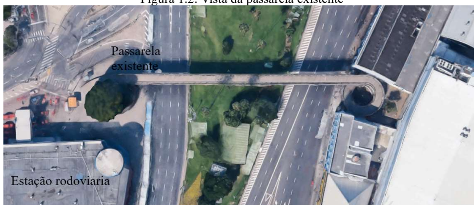
Figura 1.2: Vista da passarela existente
