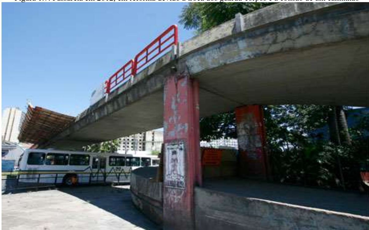
Figura 1.7: Passarela em 2012, em reforma devido à troca dos guarda-corpos e a colisão de um caminhão
