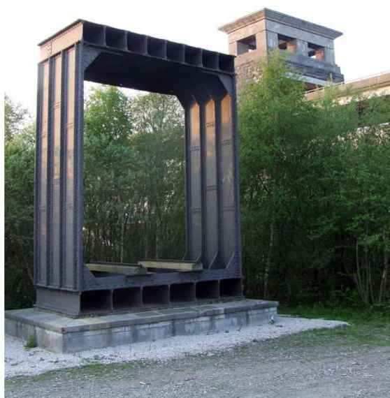
Figura 2.3: Seção original da ponte Britannia
