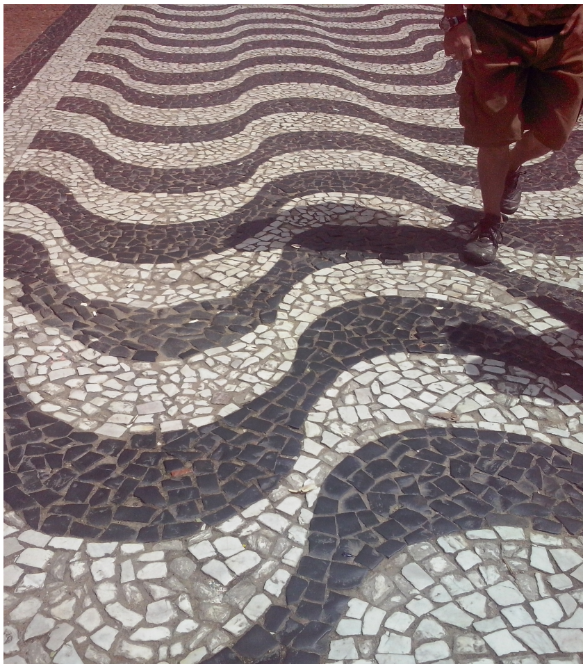
Figura 18 – Detalhe da calçada da Rua dos Andradas
