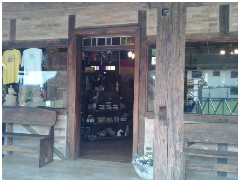
Figura 7 – Loja do parque construída em técnica enxaimel
